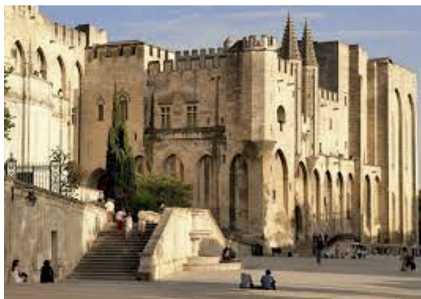
Figure IV.9.10 : Avignon, palais des Papes, photographie moderne.
